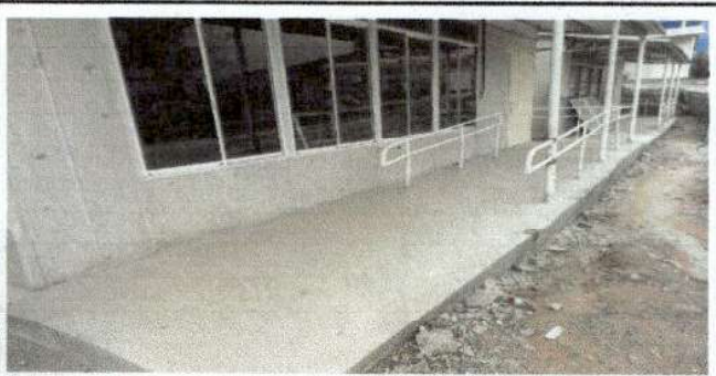
Foto 6: Así se vista el corredor y puertas de las 5 aulas finalizadas
