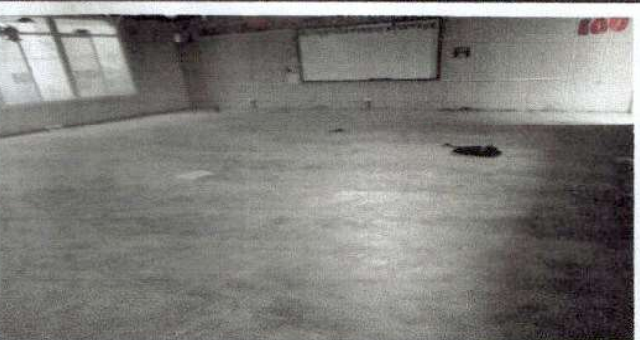
Foto 5: Las 5 aulas finalizadas con la fundición de piso y banquetas
