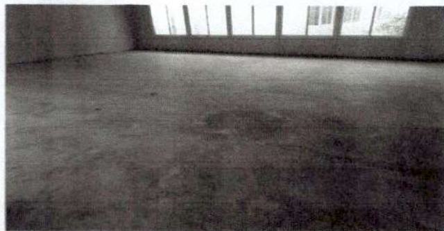
Foto1: Finalizado la fundición de piso en las 5 aulas
