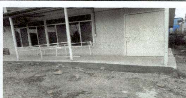
Foto 4: Finalizada fundición de piso, banquetas y puertas de las 5 aulas
