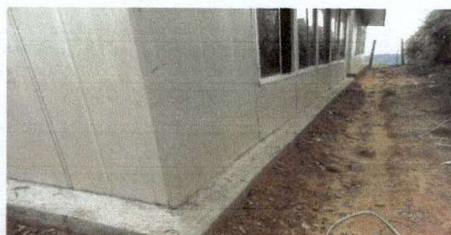
Foto 2: Finalizado la fundición de banquetas de las 5 aulas
