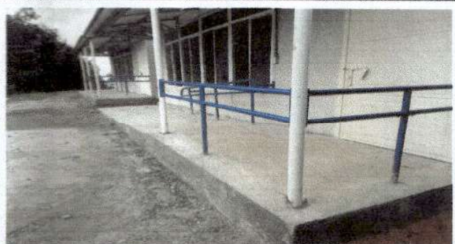
Foto 3: Finalizado la fundición piso del corredor y puertas de las 5 aulas
